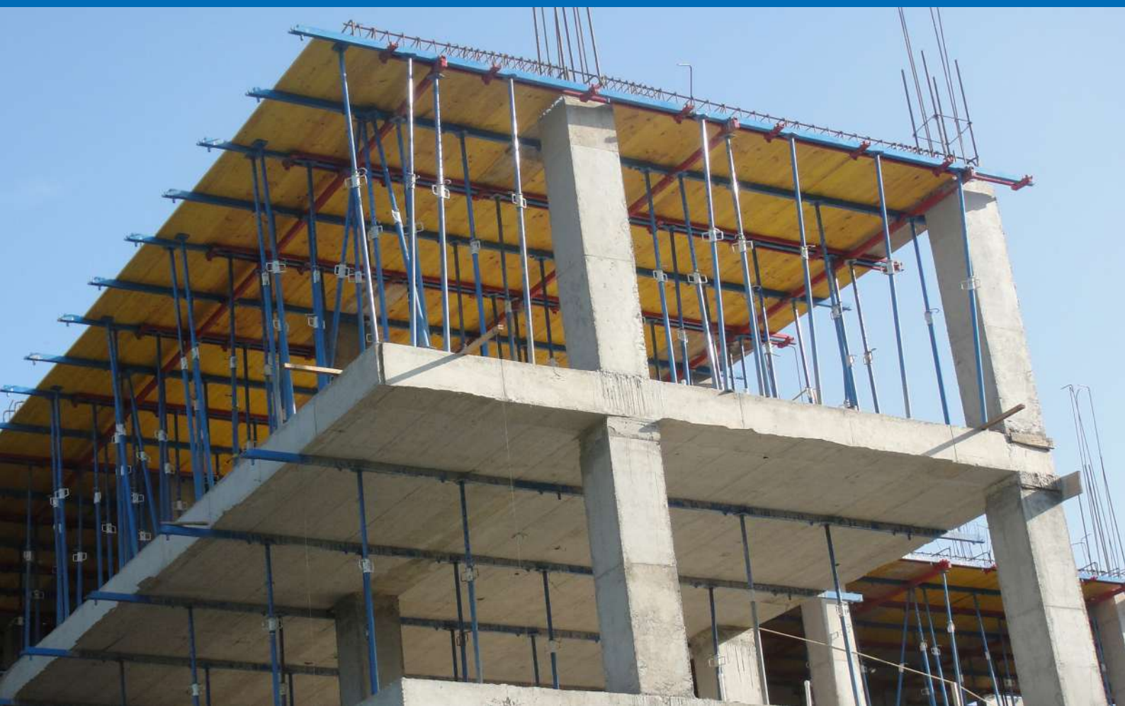
EDIFICIO INGENIERIA ELECTRICA UIS - BUCARAMANGA - COL
